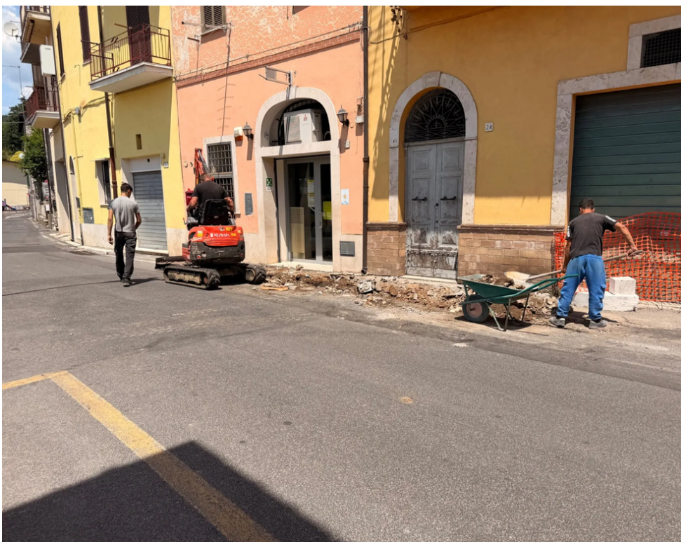
DURANTE I LAVORI
