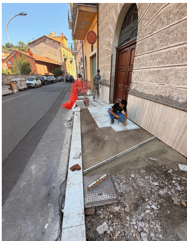
Avanzamento delle lavorazioni
