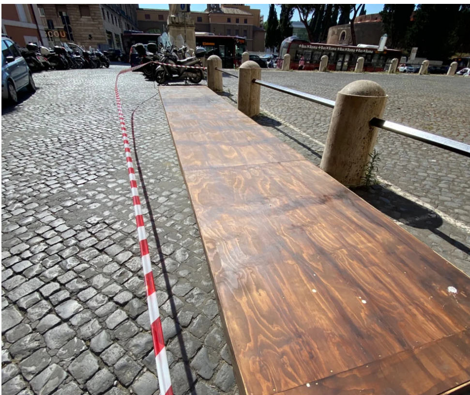
Allestimento di una passerella in legno
