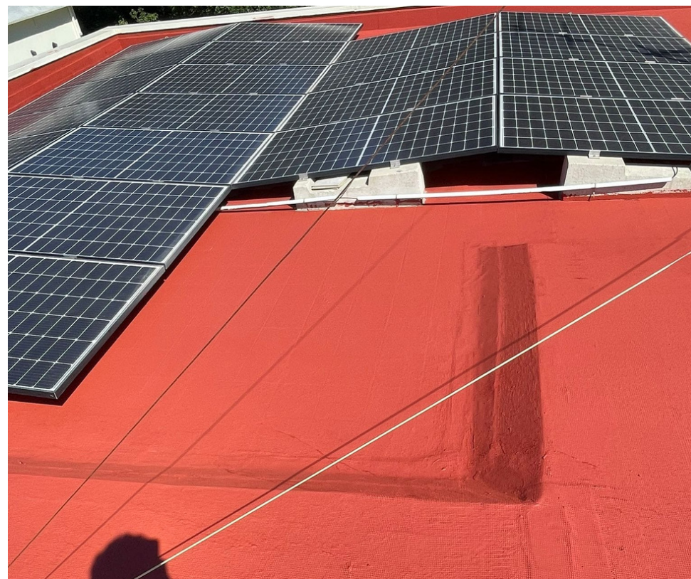
Risvolti e raccordi sulla copertura
