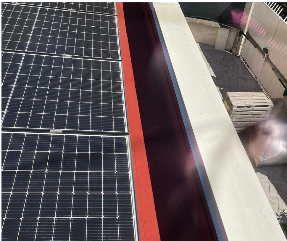
Trattamento del perimetro
