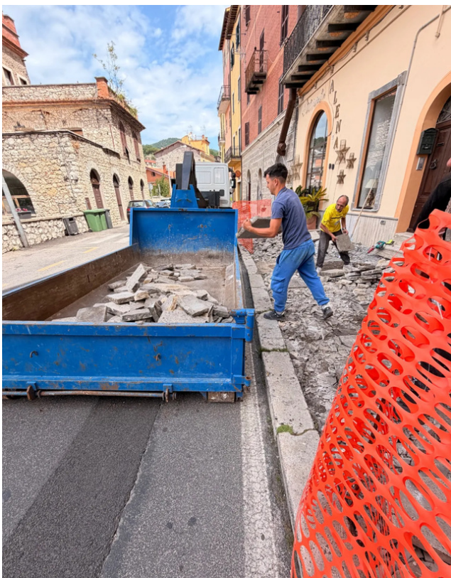
Demolizione del marciapiede
