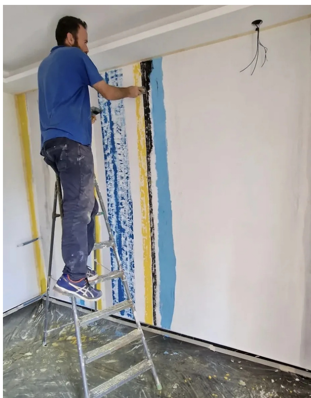
Lavorazione dei dettagli
