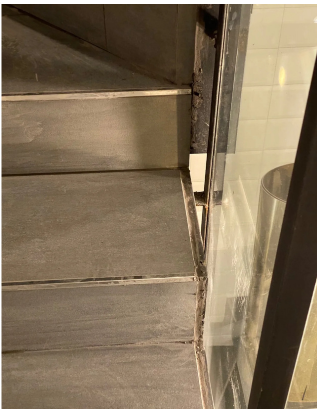
Rivestimento dei gradini
